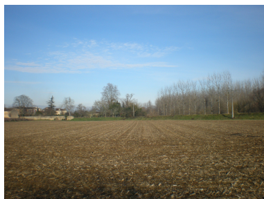
- Digue à Preignac -
