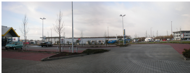
- Zone commerciale à Arbanats -
